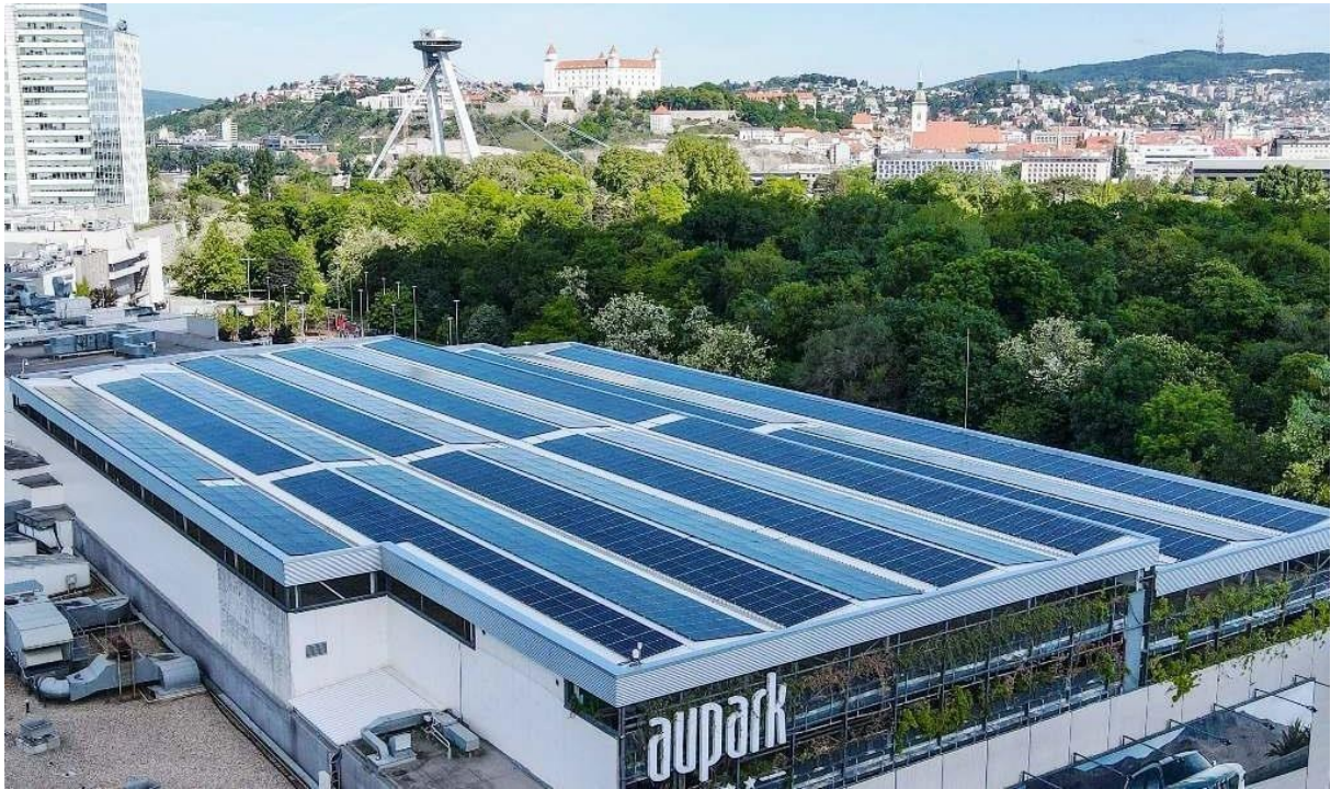
Obrázok 24 Fotovoltaický systém ako lokálny zdroj na streche Auparku v Bratislave [32]
