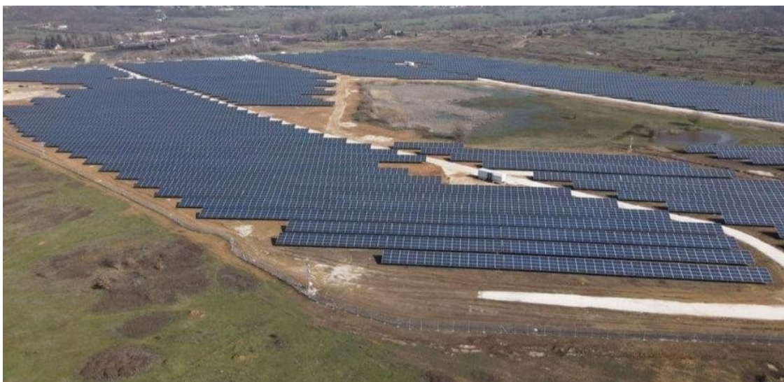
Obrázok 12. Solárna elektrárň Oslomej 1 (zdroj WeBalkans.eu)
